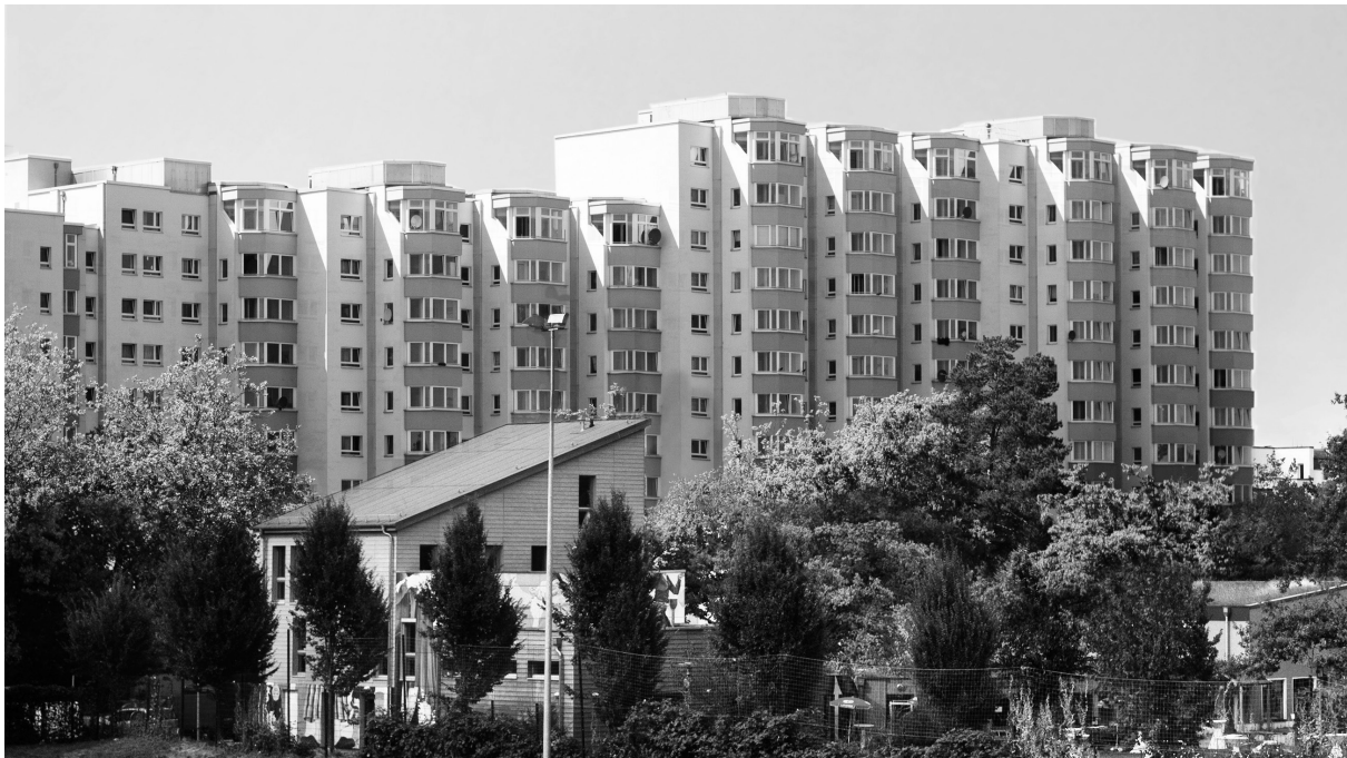
Abb. 3: Die Lenzsiedlung mit dem Bürgerhaus nach der Erweiterung 2010 (Foto: Anne Eickenberg)
