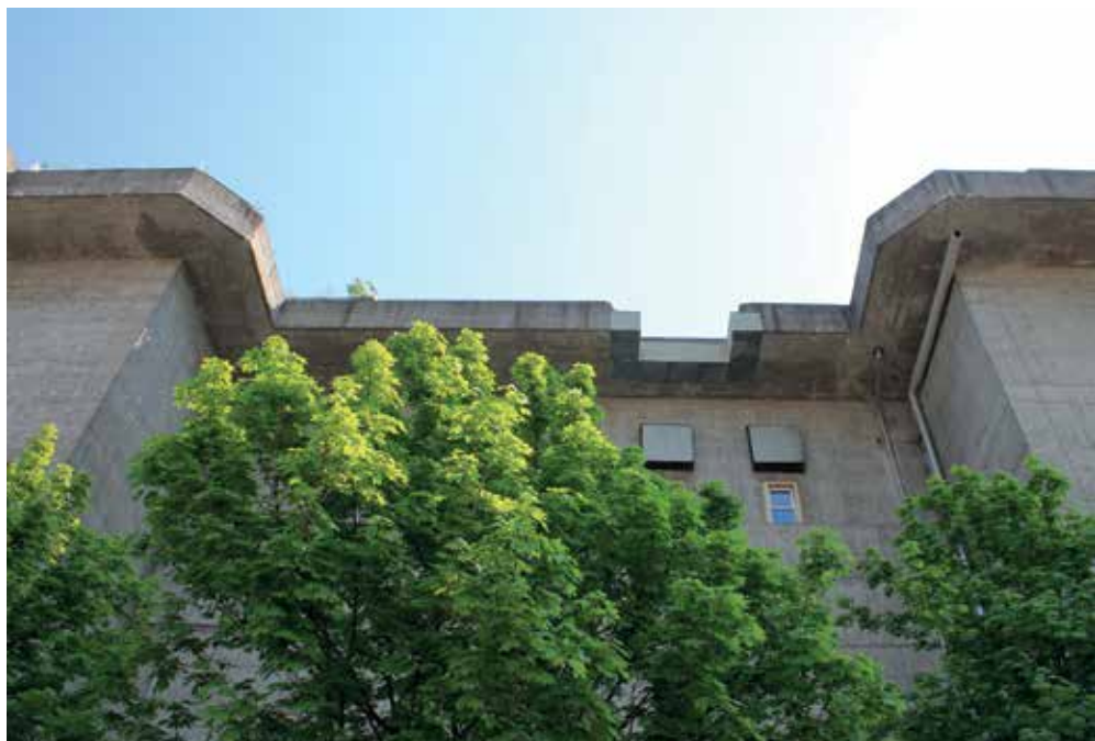
Abb. 1: Der Bunker an der Feldstraße im Schanzenviertel ist 39 Meter hoch und hat 3,5 Meter dicke Wände – zu gefährlich für eine Sprengung und zu teuer für einen möglichen Abriss. Die Frage war: Wie weiter damit? Foto: Wiebke Schröter.
