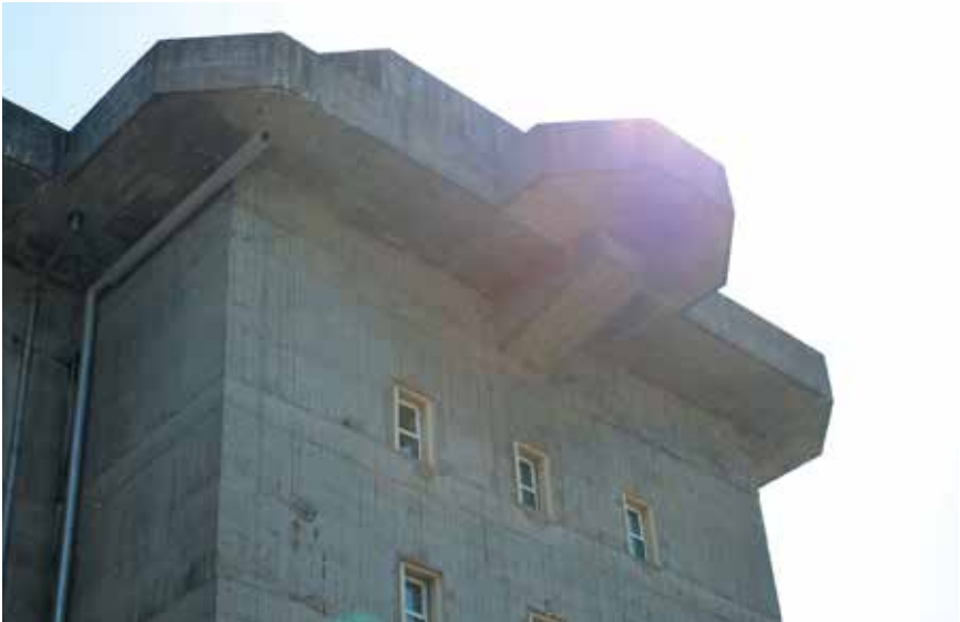
Abb. 3: Was im Bunker passiert, bleibt im Bunker: Die 3,5 Meter starken Mauern dienen dem heutigen ›Medienbunker‹ als Lärmschutz. Foto: Wiebke Schröter.
