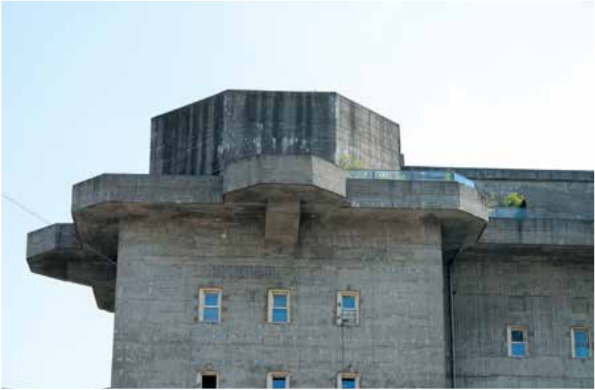
Abb. 2: Das Vorhandene nutzen: Wo früher Hubschrauber landeten, genießen jetzt die Besucher_innen zweier bekannter Hamburger Clubs die Aussicht. Foto: Wiebke Schröter.
