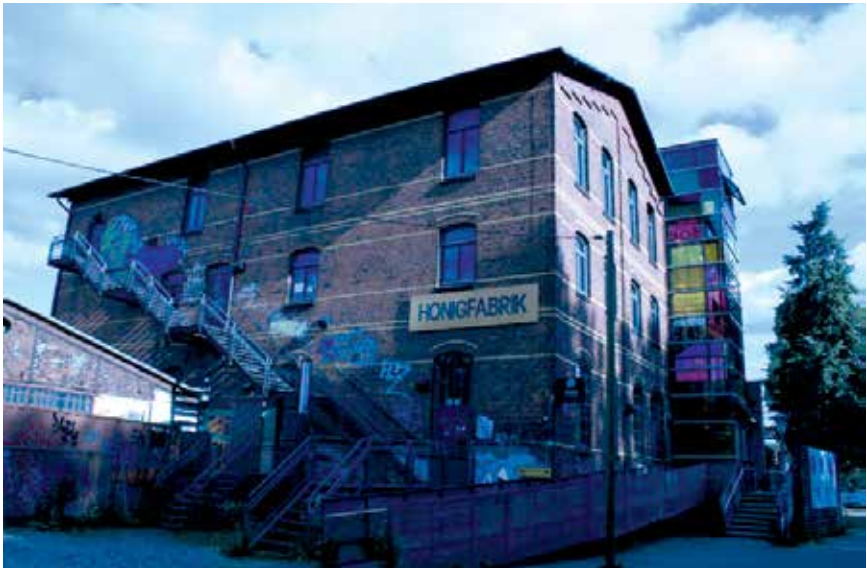
Abb. 11: Aus alt mach neu: Die ›Honigfabrik‹ vereint heute als Gebäudekomplex verbliebene alte und moderne architektonische Elemente. Foto: Wiebke Schröter.
