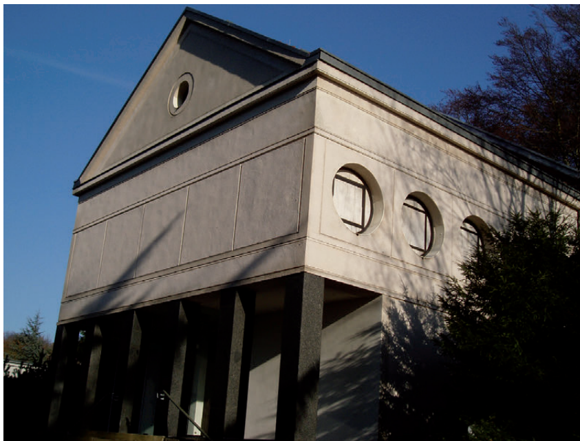
Abb. 2: Das vom Reformarchitekten Peter Behrens entworfene Krematorium in Hagen/Westfalen zählt zu den ersten modernen Bauten. Foto: Norbert Fischer
