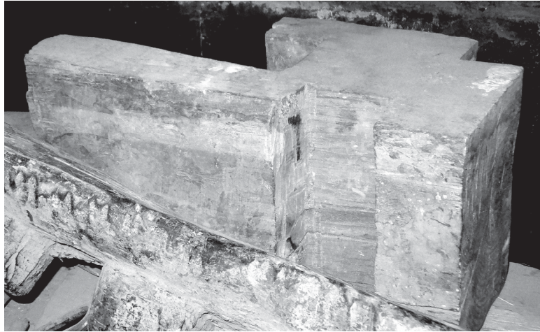
Plate 3: Church of Yəmrəḥannā Krəstos, Wällo, quoin block, photo: MG-2013
